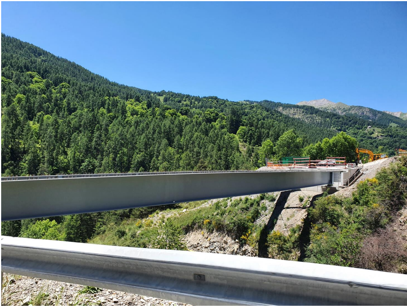
Poutres sur culées – Cozzi-Colas - 2022
