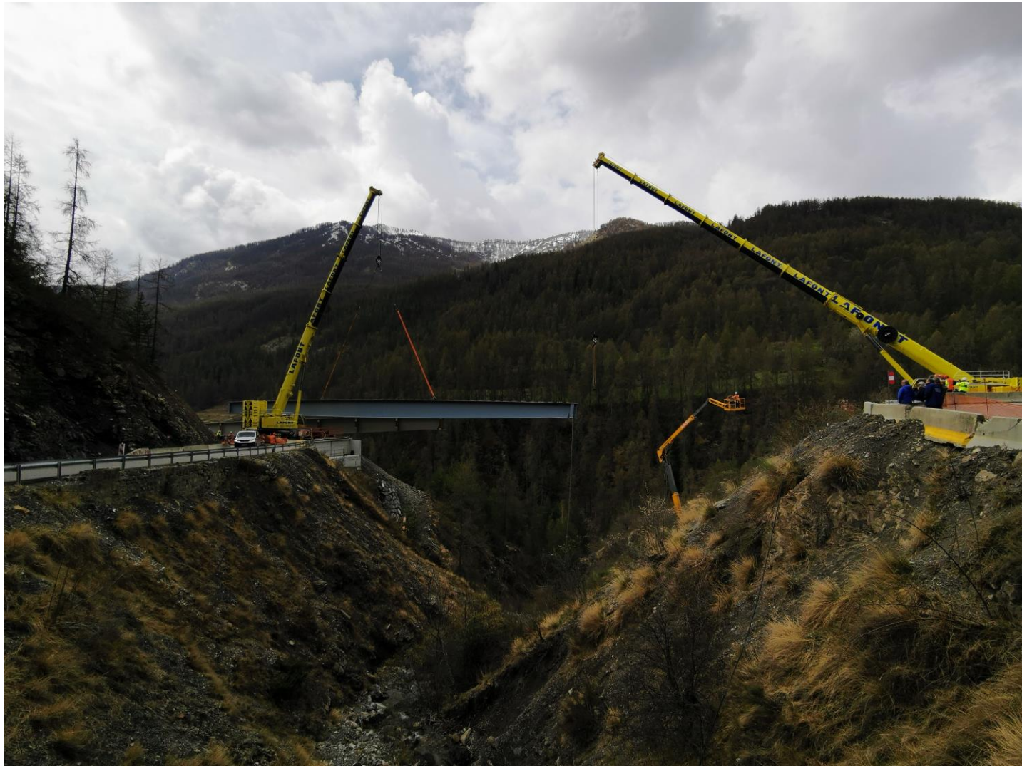
Pose des poutres – Cozzi-Colas - 2022
